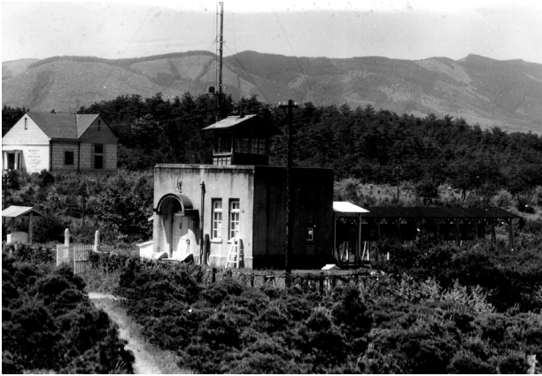
図2 北東から撮影した空中電気室（中央）。現在では木々で隠れてしまっている第一絶対室（左奥の建物）まで見渡すことができる。（1959年）
