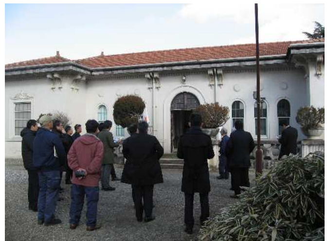
写真3 大正時代の建物（本館）
