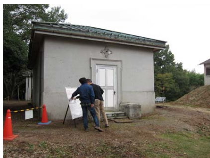
写真8 第二変化計室（新室）も大正時代の建物
