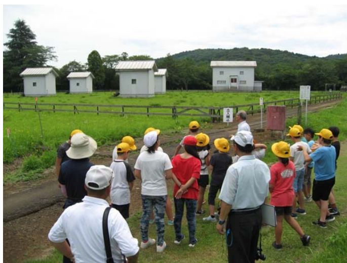
写真4 昭和47年に完成した観測棟群 (それぞれの建物に磁力計を設置している)
